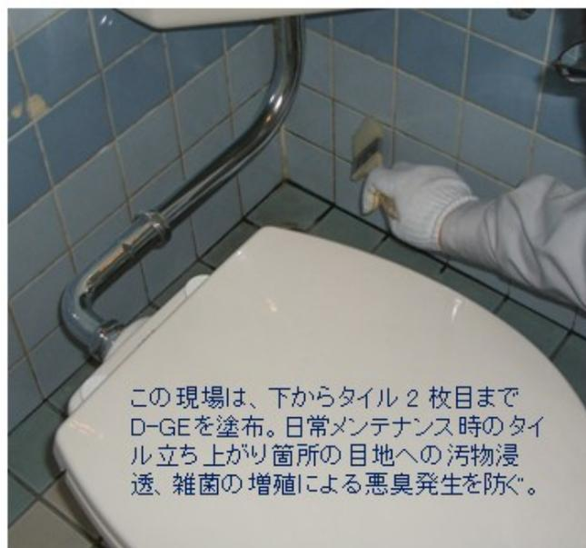
この現場は、下からタイル 2 枚目まで D-GE を塗布。日常メンテナンス時のタイル立ち上がり箇所目地への汚物浸透、雑菌の増殖による悪臭発生を防ぐ。
