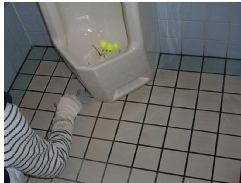
尿の染み込み防止、悪臭発生防止、メンテナンス性向上の為、D-GE をタイル目地に十分に浸透するように塗布。
