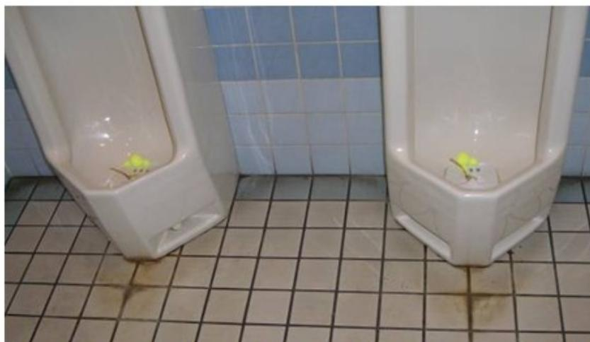
尿の染み込みによる雑菌の増殖により悪臭が発生している→除去清掃→充分乾燥させる(脱脂及び日常メンテナンス材も除去)
